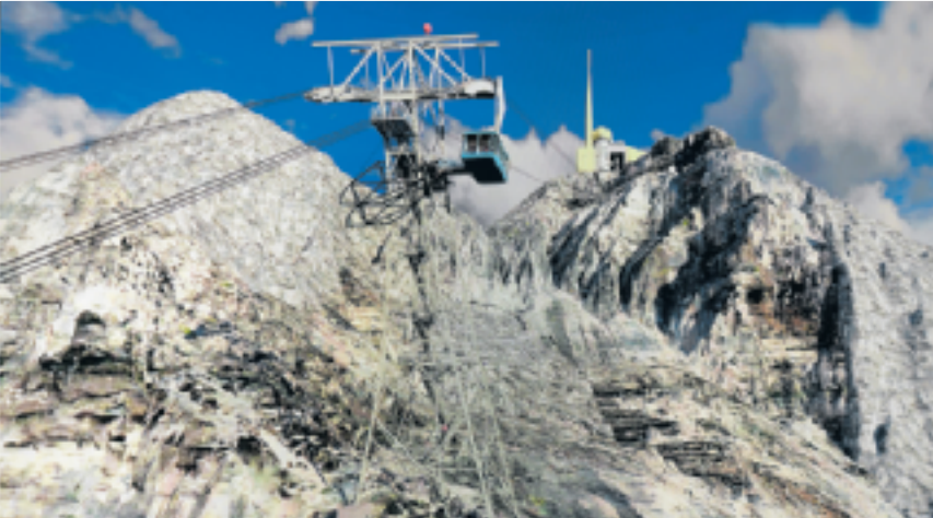
Die künftige Konstruktion am Platz der heutigen «Stütze II» wird 43 Meter hoch und weist eine Spurweite von 15,2 Metern auf. Ein Aus- und Zustieg wird auch künftig möglich sein. (Bilder: Hans Ulrich Gantenbein)
